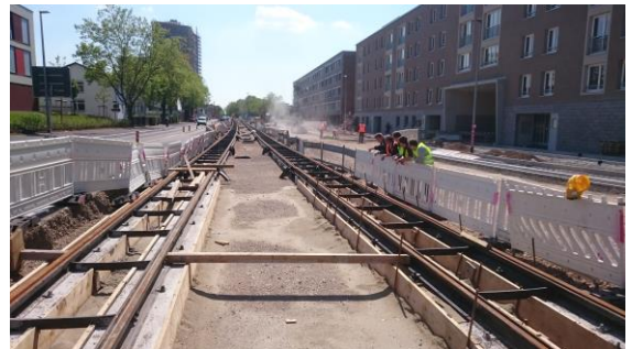
Auf der Baustelle
