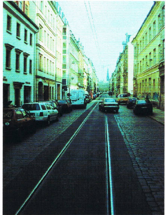
Betrieblicher Engpass: eingleisiger Straßenbahnabschnitt, befahren in beiden Richtungen zusammen mit dem Straßenverkehr
