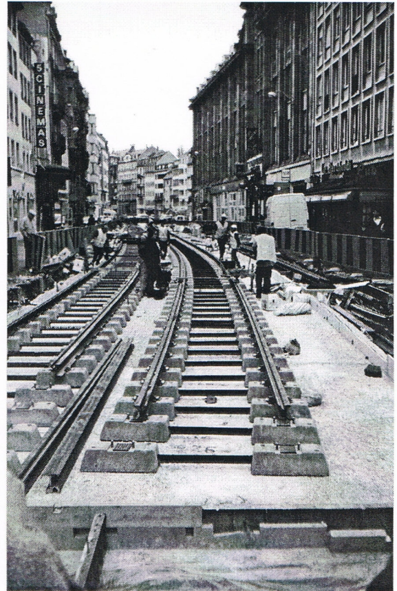
Gleisbauarbeiten für Linie B
